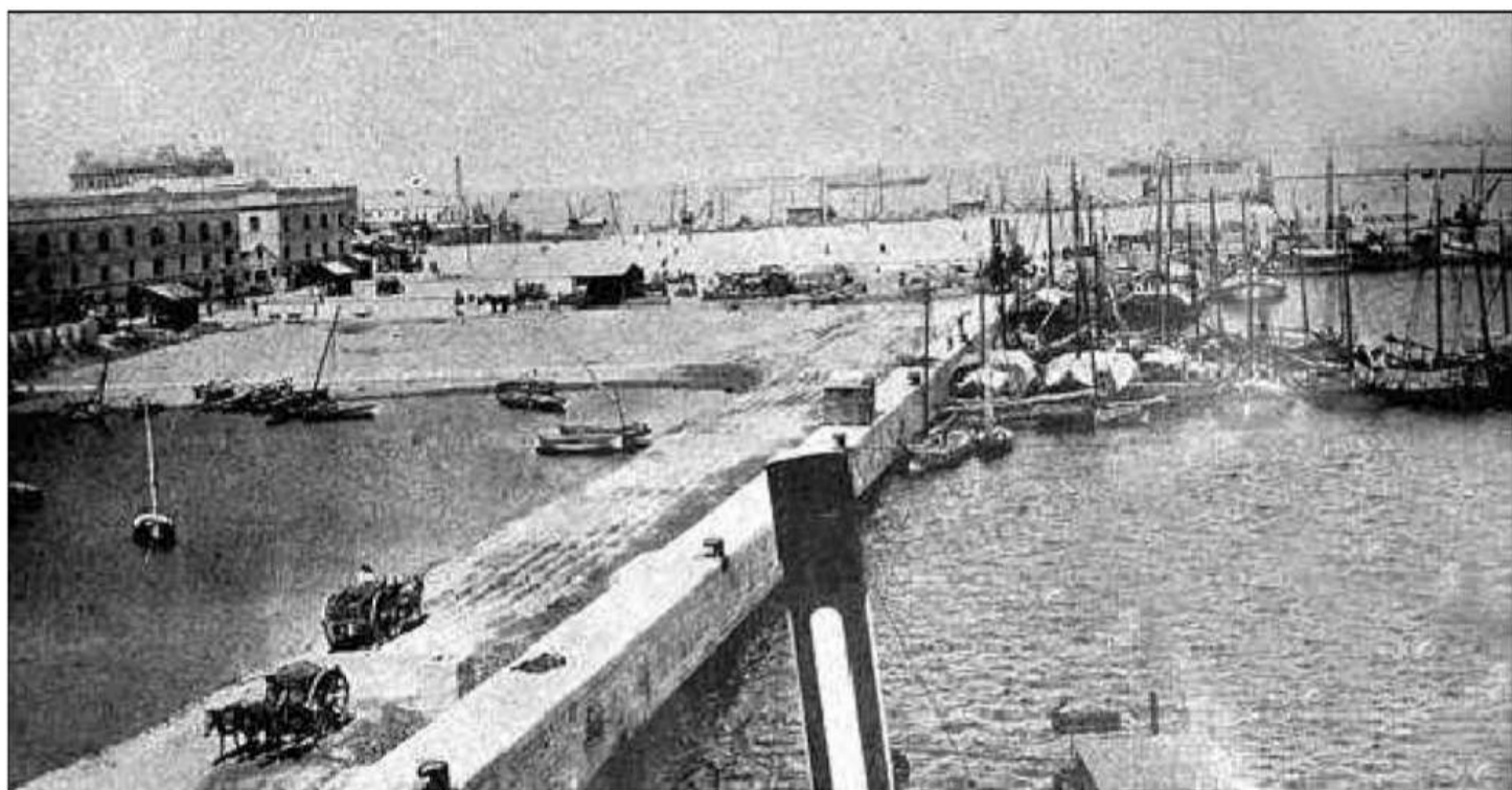
1903. Construir el puerto fue consecuencia de la intensa actividad marítima que venía desde 1776 en el Apostadero Naval.
