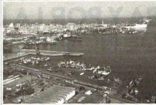
El muelle C es una de las principales obras del puerto de Montevideo
